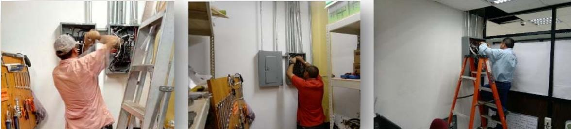
Figura 60. Instalación de contactos monofásicos, trifásicos en laboratorio de ingeniería mecánica e interruptores en oficinas de ed. A y sala magna.
