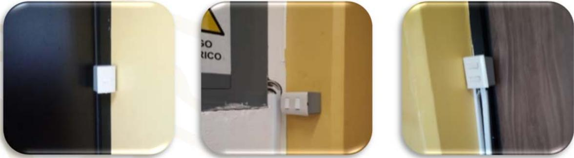
**Figura 54.** Reubicación de apagadores en arbotantes de ed. E, aula 06 y pasillo planta alta de ed. A
