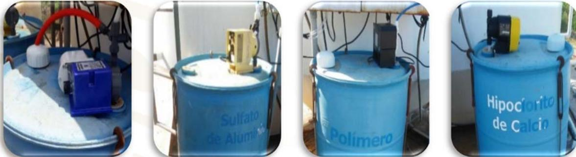
Figura 49. Reparación de dosificadores en planta potabilizadora
